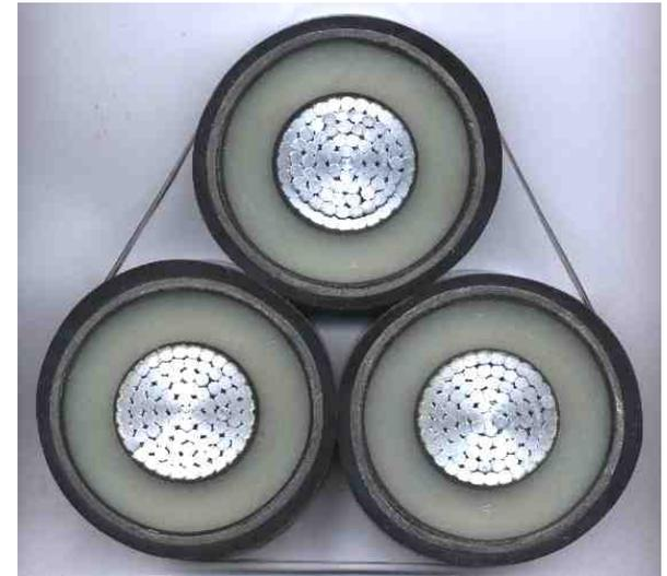
**Valable aussi pour l'éolienne :** triphasé ; enveloppe métallique mise à la terre + distance.
